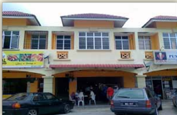
Bangunan Kedai Pejabat, Permint Jaya, Chendering, Kuala Terengganu
